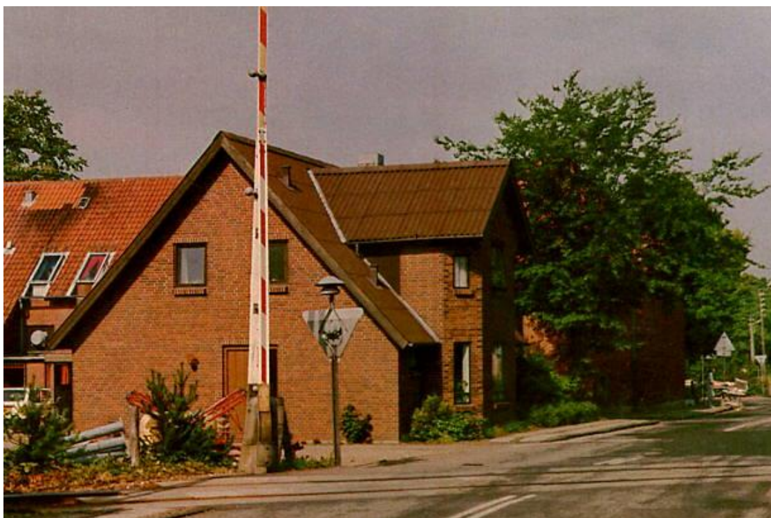
Omslagsbillede fra "Tvis Sogn" 1987. Som det ses har Hovedgaden 4 fået en "overhaling" - ny ydervæg, nye vinduer, nyt tag og ny indretning. Bøgetræet ved gavlen, der oprindeligt var en hækplante, fyldte godt
