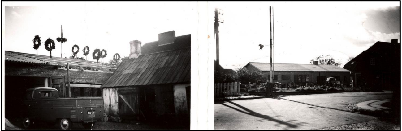
På billede 1 er der rejsegilde på den nye tilbygning. Det gamle værksted står fortsat. Billede 2 viser det sammenbyggede værksted, og at det gamle værksted er fjernet.
