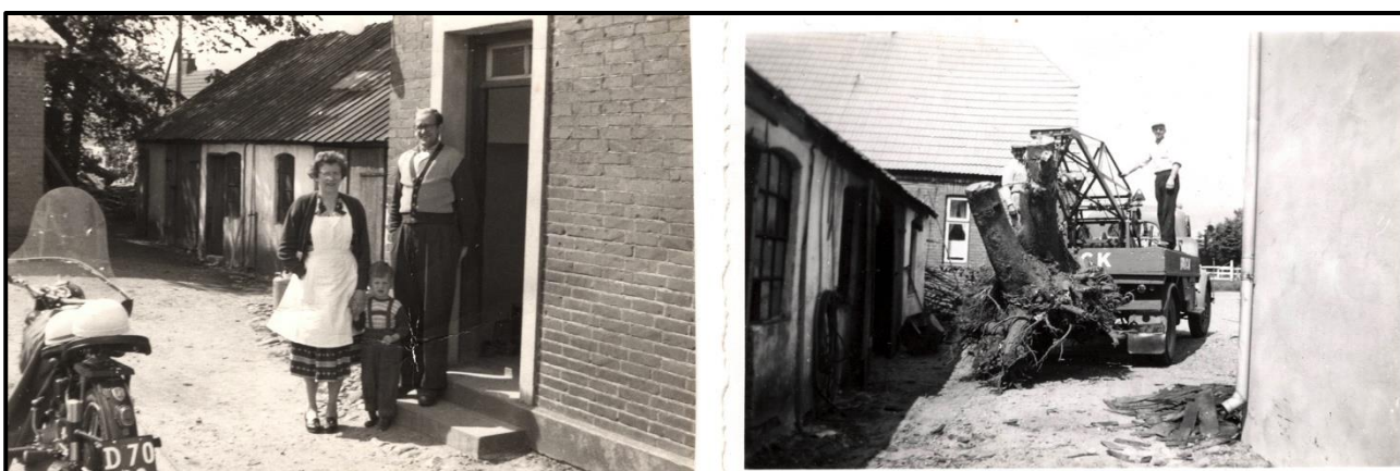
På billede 1 ses bag Kjeld, Gutte og Svend, elmetræets placering imellem de to bygninger. På billede 2 ses en stolt Falckmand der endelig fik has på træroden.
