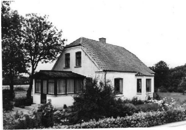
Kabbels, som den så ud efter renoveringen.
