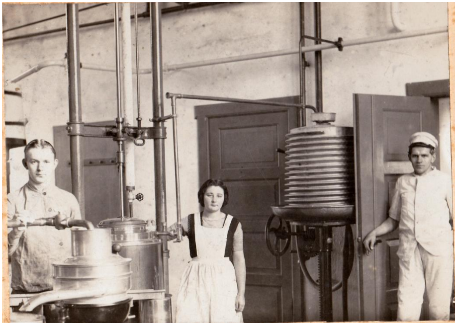
Figur 38. Inde fra Tvis mejeriet ca. 1917. På billedet ses mejerist Holst, tjenestepigen + mejserske Ellen og mejeribestyrer Søren Giver. På billedet ses centrifugen og det rillede apparat til temperaturbehandling af fløden.
