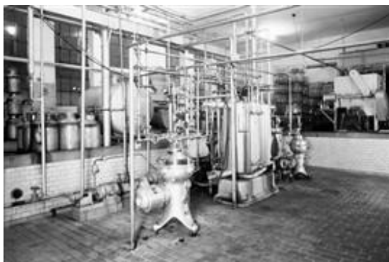
Figur 27. Mejeriinteriør. Fliser på gulv og vægge
