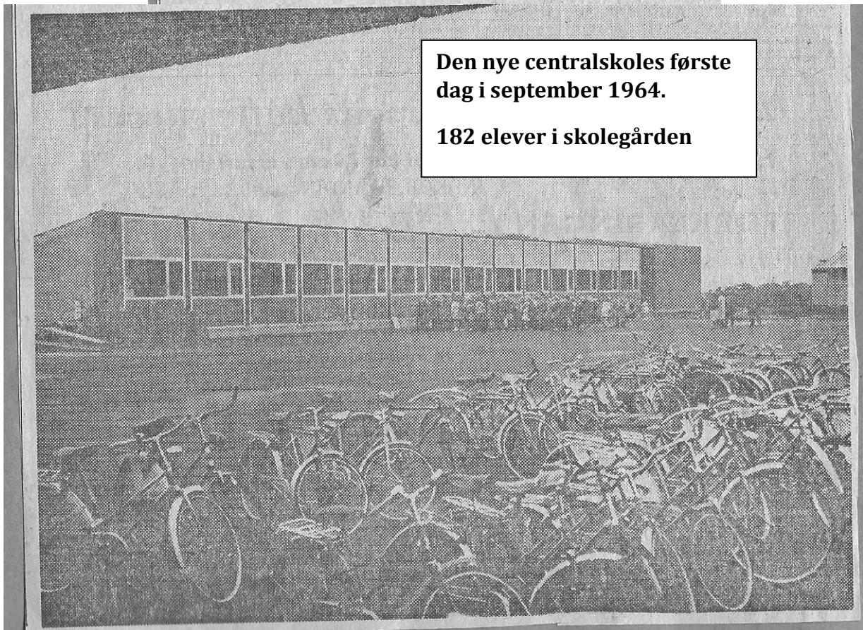
182 elever(her opstillet i skolegården) klar til at tage den nye skole i brug.
