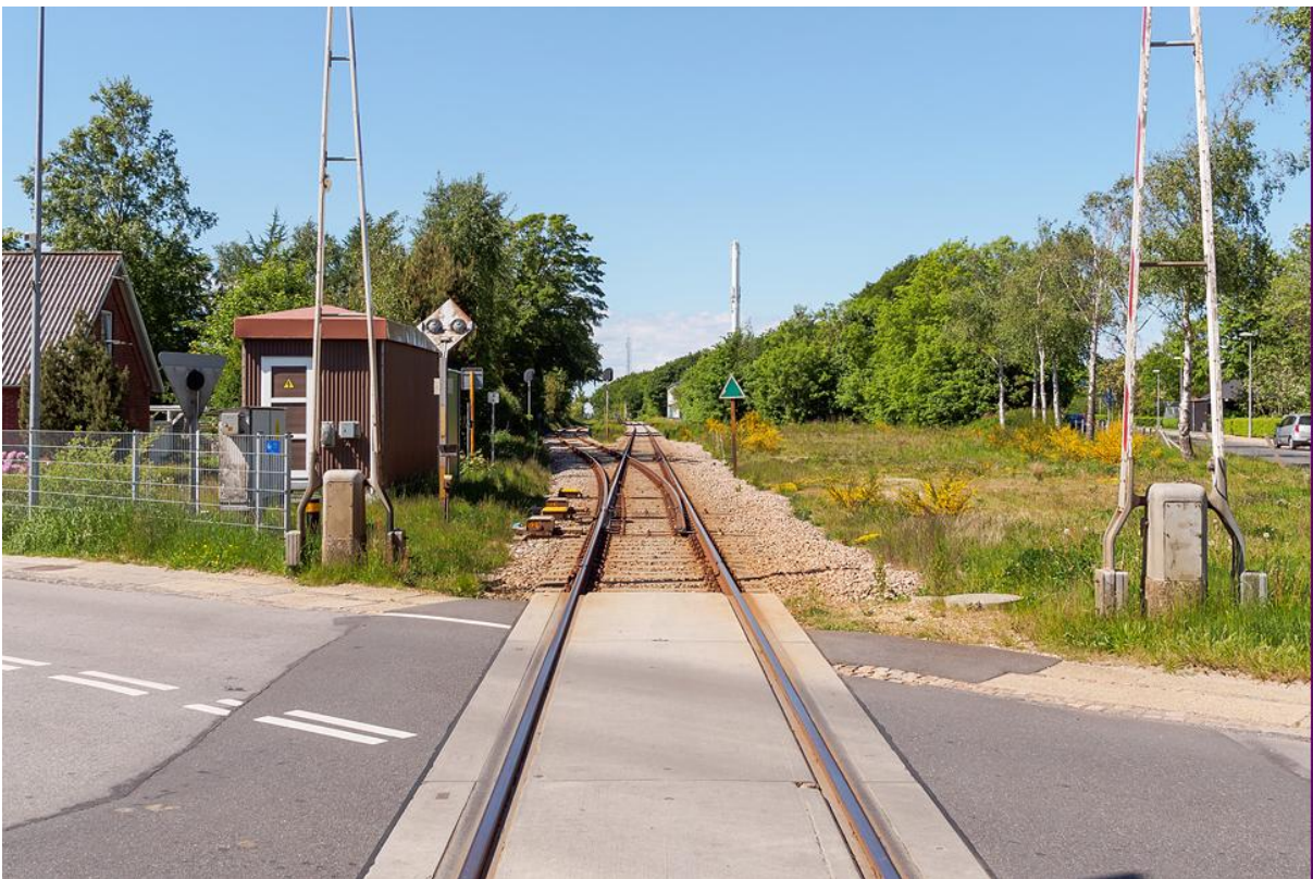
Overkørsel - hovedgaden i Tvis 2013. Det tidligere vogterhus til venstre. Foto T. Rithmester.
