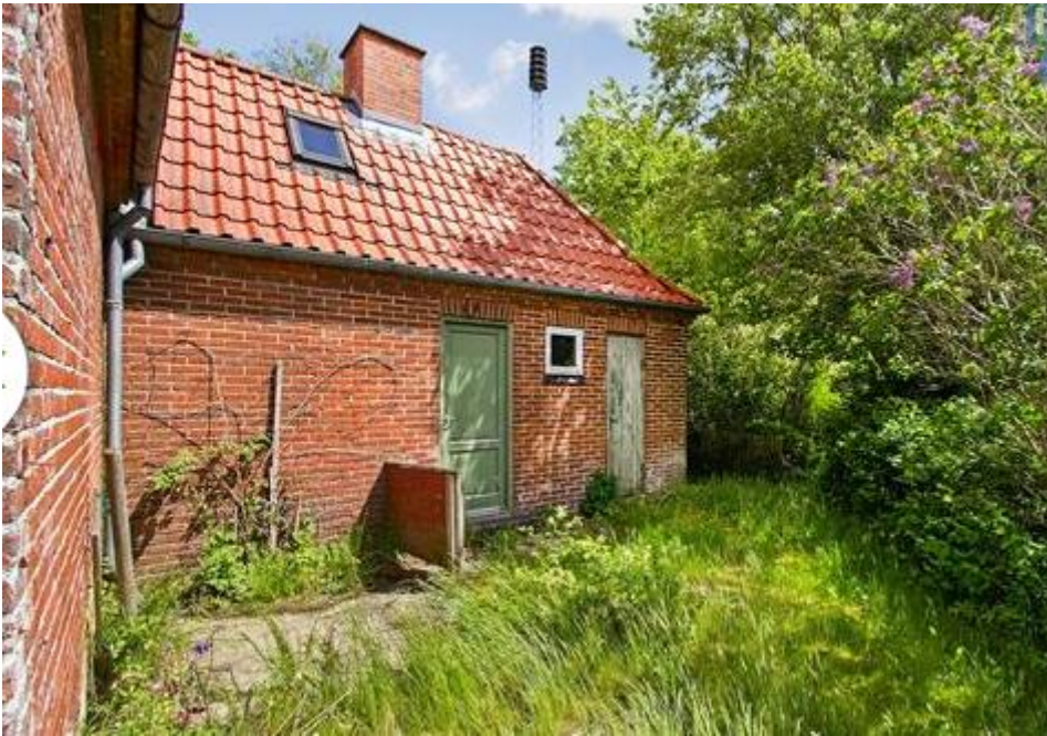
Den tidligere portørbolig 2015
