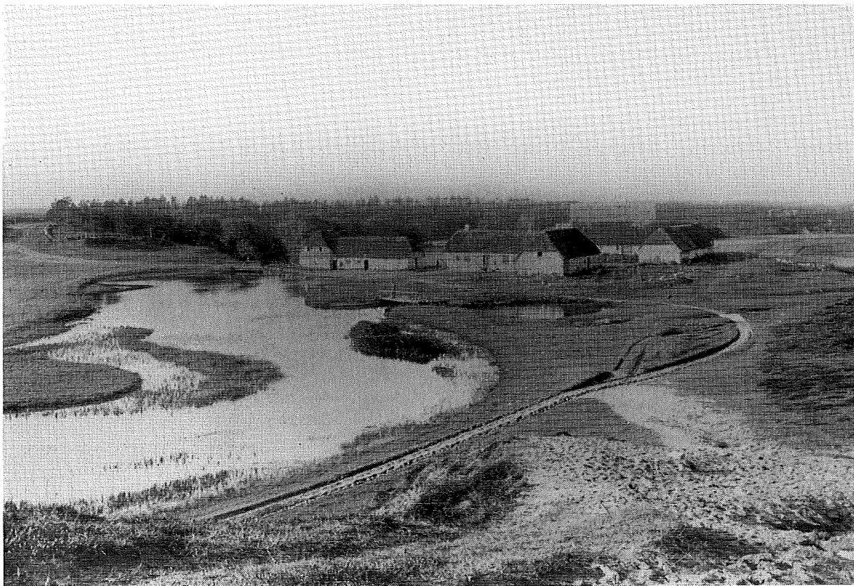
Da herregården nedrives og flyttes bort fra øen, opstår Tvis mølle gård i den østlige ende af klosterøen. Af de bygninger, der ses på billedet, er det kun møllehuset ved møllebroen til venstre samt muligvis tilbygningen, som stammer fra herregårdsperioden. - Bemærk tagryggen på Tvis gamle kirke i baggrunden. Billedet er formentlig taget kort før kirkens nedrivning i 1889 fra skrænten ved den nu nedlagte vej nord om mølledammen.
