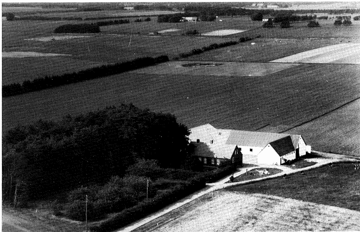
Laulund, som Christian Skautrup Andersen bygger omkring 1912, og som stadig er i slægtens eje, ligger på Lauralyst jorder, der ved læhegnet til venstre grænser op til Majgård jorder. I forgrunden ses en bid af Herningvej. Billedet er taget omkring 1970.
