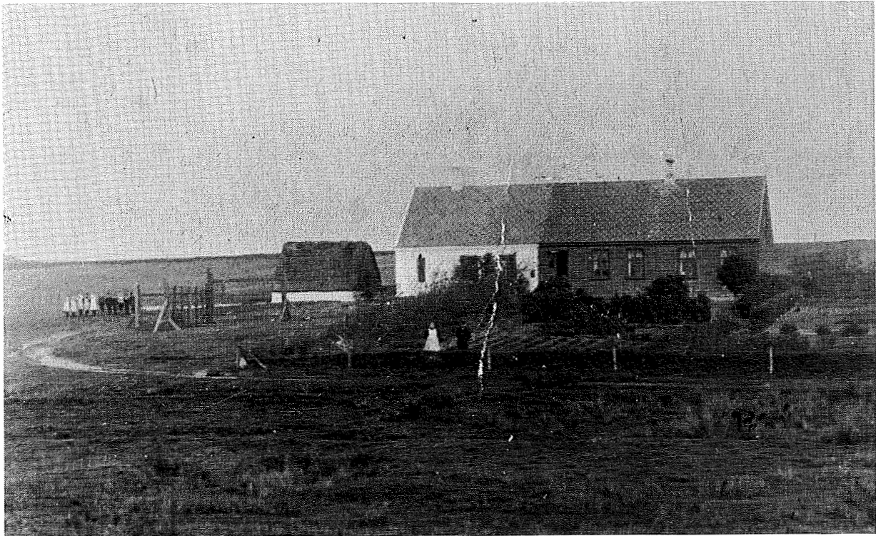
Dette billede af Skautrup skole viser, hvor øde den lå, før plantagen blev anlagt i 1917. Til den hvidkalkede skolestue fra 1871 bliver der i 1902 tilbygget en lærerbolig. Det er vist nok lærer Niels Jensen Skautrup og hans kone, som står nede i haven foran skolen. Elleve skolebørn er opstillet på rad og række ved skolens gymnastikredskaber til venstre i billedet.
