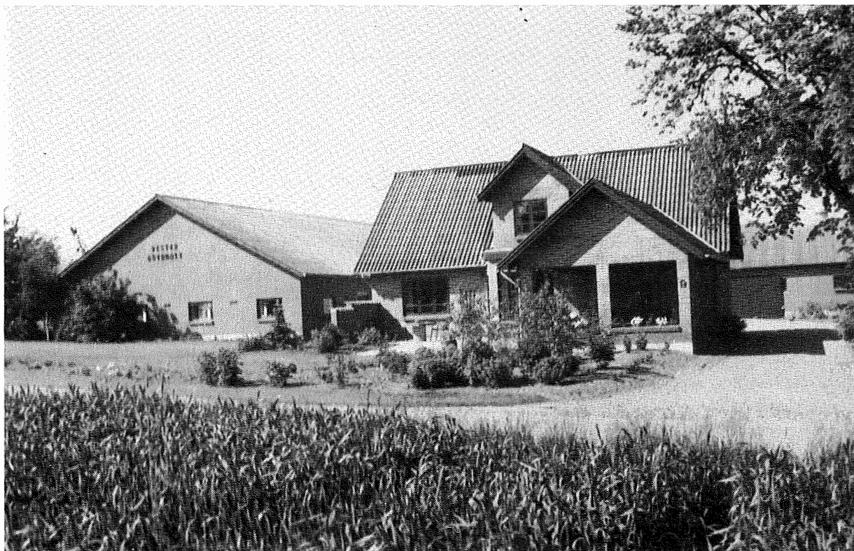
Vester Grydholt brændte i begyndelsen af 1930'erne, og nye bygninger blev opført på stedet. Af dem eksisterer kun stuehuset, som i dag er ombygget og moderniseret. Aulsbygningerne er nyopførte i Ernst Brødbæks tid.
