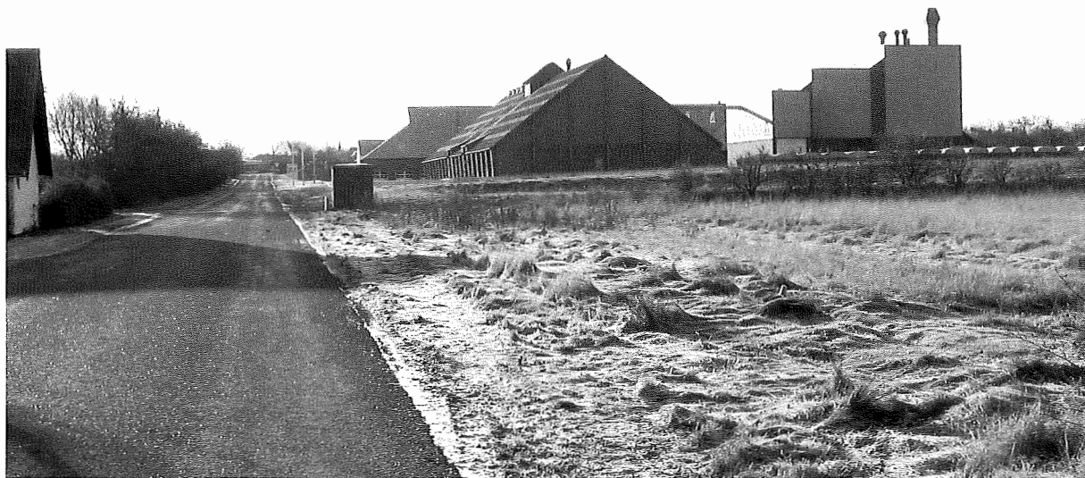
Foderstofforretningen HAG er indgået i Østsjællands Andelsgrovvareselskab under navnet ØA.
