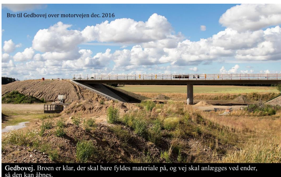
Bro over motorvejen ved Gedbovej juli 2016
