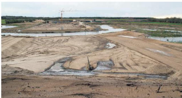
Byggepladsen set fra nord afspejler, at man ikke sådan uden videre sætter over Storåen. Til højre på fotoet ses, hvor der snart skal etableres en midlertidig arbejdsbro. På den anden side af åen er der banket betonpæle langt ned til fast underlag, hvorefter der skal støbes fundamenter oven på pælene. Længere oppe kan man nøjes med at jordfundere til søjlerne. Foto: Ejgil Basselbjerg
