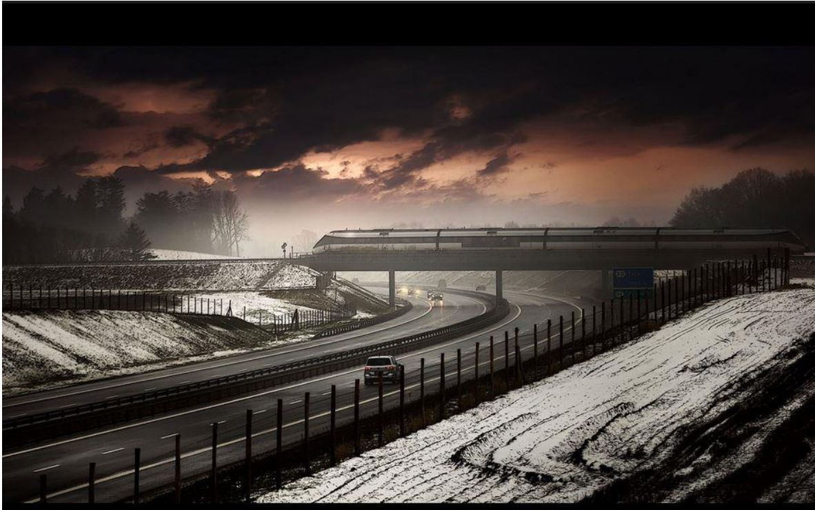
Efter åbningen vinter 2018/19 med kørende biler på motorvejen og IC 4 toget over.
