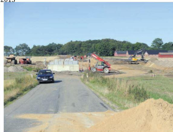
Tvisborgerne kan allerede nu fornemme, hvor og hvordan Gedbovej tæt på byen vil blive ført over motorvejen via en ny bro, der bliver ni meter bred. Foto: Frede Rosenberg
