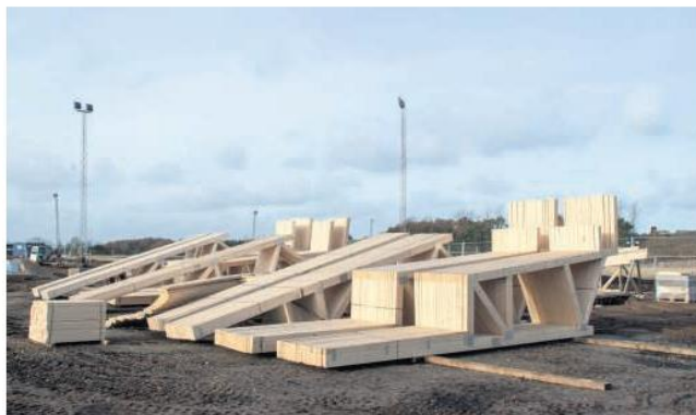
De kraftige trækonstruktioner er beregnet til at bære brodækket under støbearbejdet. Foto: Ejgil Basselbjerg
