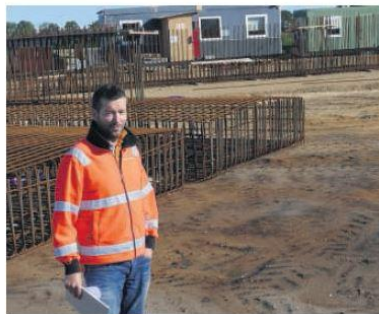
Projektleder Martin Andersen glæder sig til udfordringen ved at bygge hele fire broer over Holstebromotorvejen. Her på arbejdspladsen fylder armeringsjernet allerede godt op. Foto: Frede Rosenberg
